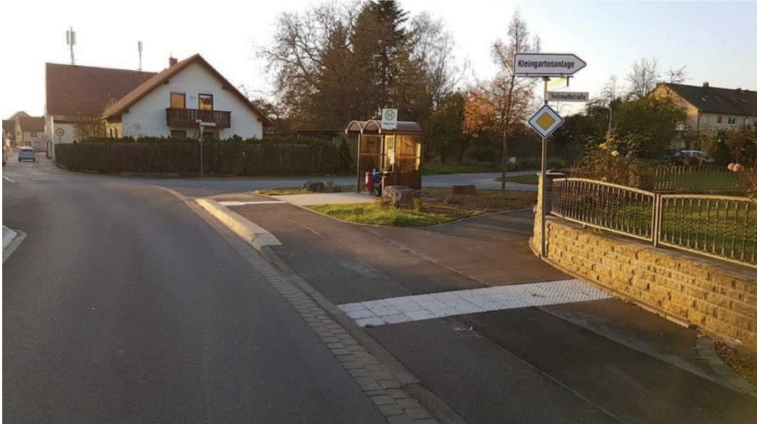
Abbildung 24: Niederwerrn Obertor: Fahrgastunterstand, Sonderbord, Auffindestreifen und barrierefreie Querungsstelle in unmittelbarer Nähe. (Quelle: Haltestellenkataster Landkreis Schweinfurt)
