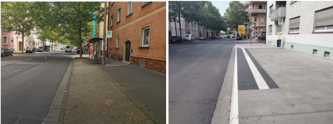
*Abbildung 49: Bushaltestelle mit Richtungshaltestellen mit unterschiedlichem Ausbaustandard nach dem jeweiligen „Stand der Technik“ (Haltestelle Luitpoldstraße, links stadteinwärts, rechts stadtauswärts)*
