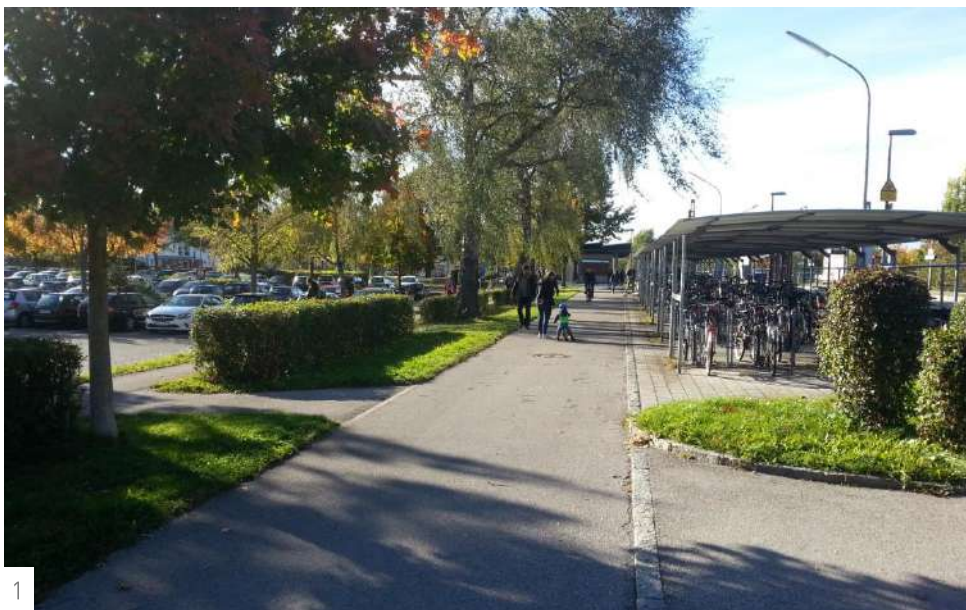
Bild 1: Die Zufahrt zur Radabstellanlage an einem Bahnhof erfolgt über einen Radweg. Dieser ist sowohl vom Gehweg als auch von der Fahrbahn getrennt. Die Verkehrswege sind großzügig dimensioniert, frei und sicher. Positiv ist zudem die Lage sehr nahe am Bahnsteig.
