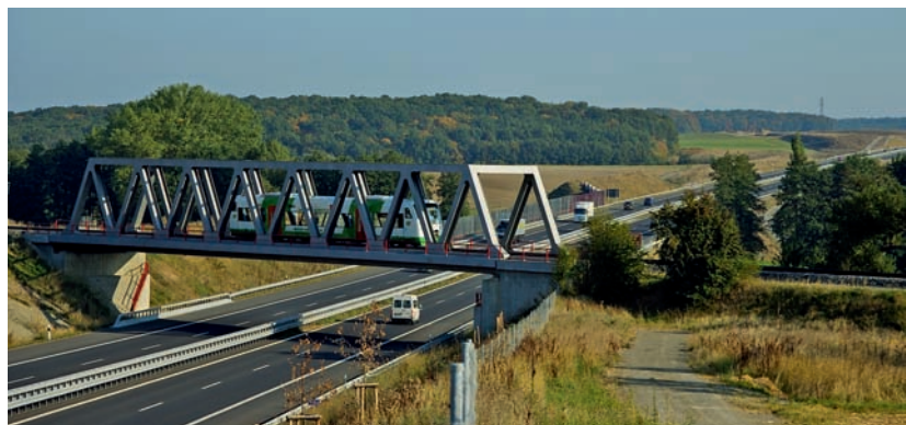
Bahnlinie zwischen Oberwerrn und Poppenhausen
