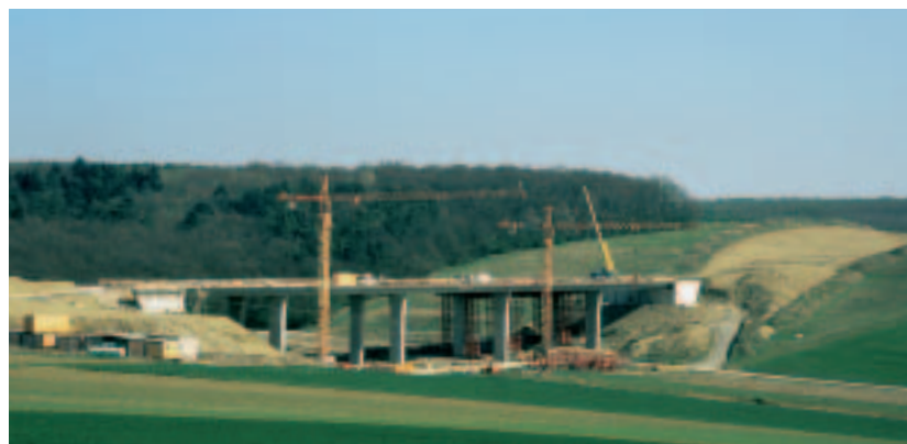
Brückenbauwerk der A 71 zwischen Hain und Pfersdorf
